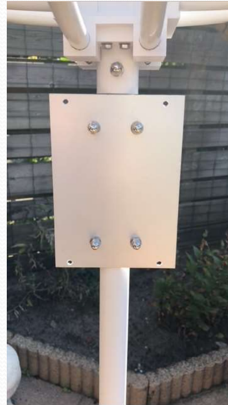
Achterplaat wordt met omgebogen draadstang aan de mast gemonteerd
